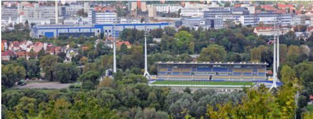
Idyllisch gelegen: das Ernst-Abbe-Sportfeld in Jena soll zur Multifunktionsarena umgebaut werden. Foto: Tino Zippel
